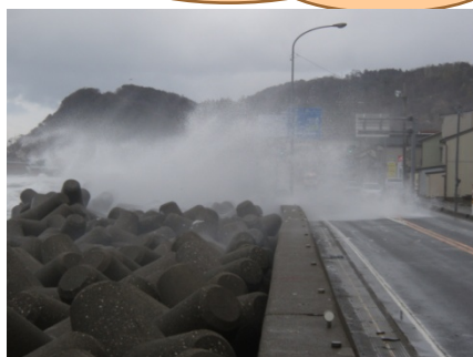
国道8号 越波による被災状況
